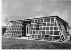
ANSICHT VOM SÜDOSTEN
