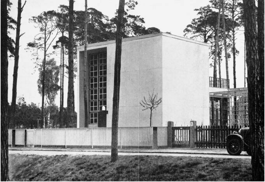
Abb. 8: Ansicht von Arnold Zweigs Atelierhaus in Berlin-Charlottenburg, Architekt: Harry Rosenthal, 1932.
