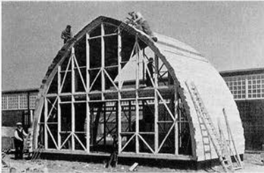
EINSETZEN DER GIEBELWÄNDE. 2. TAG DER MONTAGE
