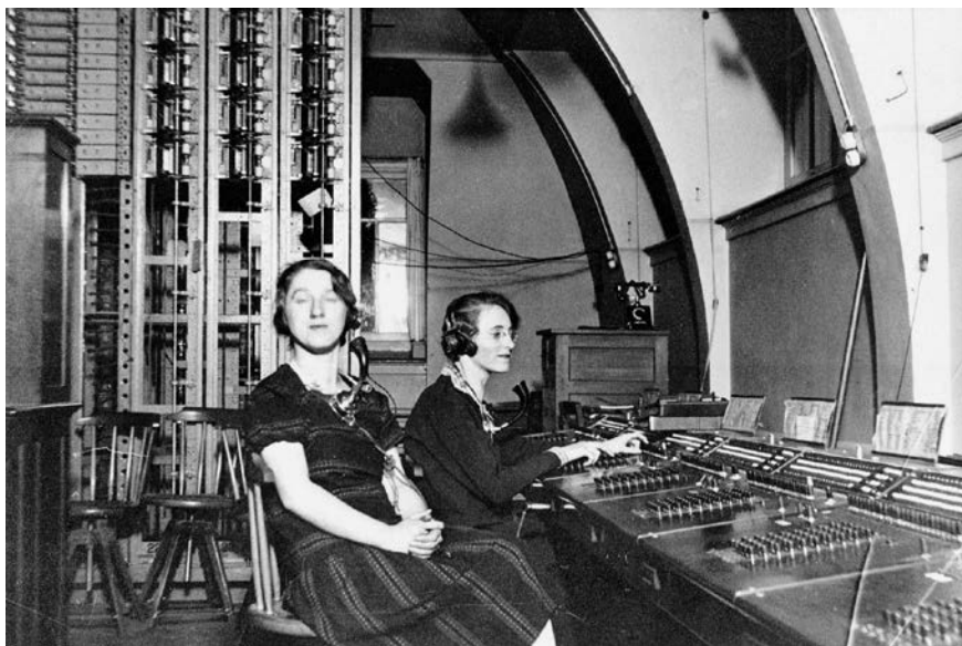
Abb. 9: Halbautomatische Telefonzentrale in Zürich Hottingen. Zwei Telefonistinnen sitzen vor dem Vermittlerpult mit Tastatur, im Hintergrund das Wählergestell mit den elektromechanischen Wählern (rechts oben), 1923.
