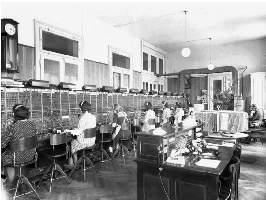
Abb. 2: Innenansicht der Telefonzentrale Thun, 1944.
