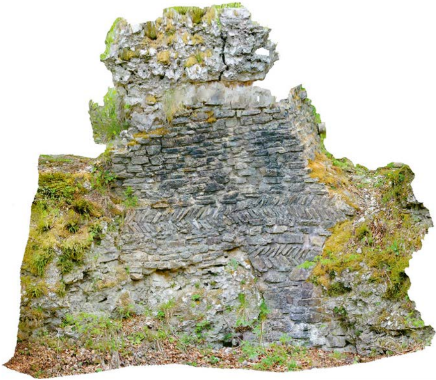
Abb. 16: Burg Sachsenstein bei Bad Sachsa: Rundturm der Kernburg, Structure-from-Motion-Modell der Innenschale (Sommer 2024) (Fotos und Montage: Clemens Ludwig, Niedersächsisches Landesamt für Denkmalpflege)
