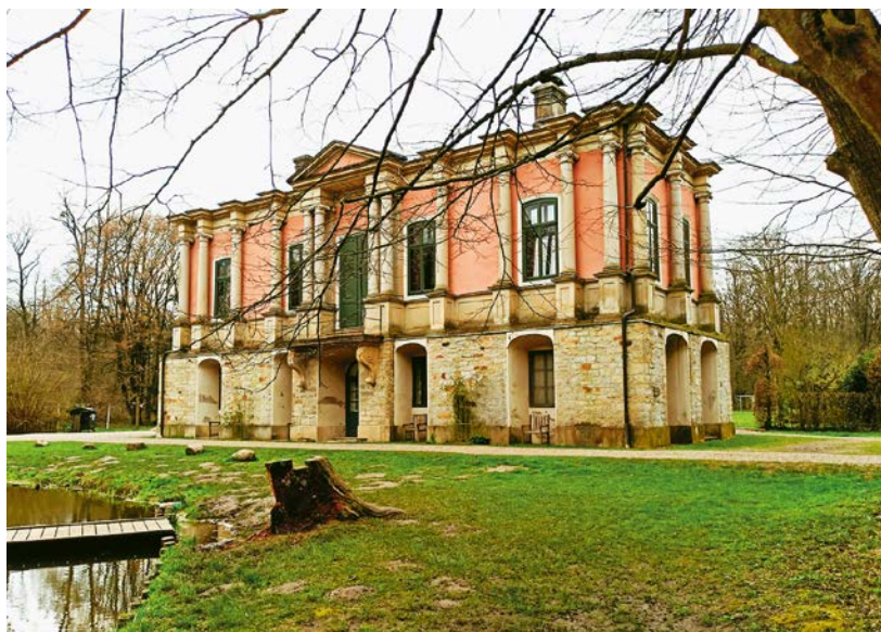
Abb. 8: Schloss Baum, Nord- und Seitenfassade, 2024 (Foto: Thorsten Albrecht)
