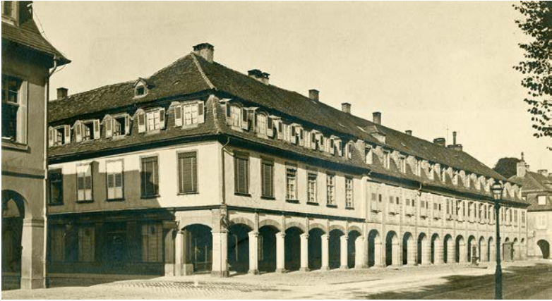
Abb. 5: Die herausgehobene Stellung Salomon Meyers zeigt auch sein Haus in Karlsruhe, Ecke Schlossplatz/Ritterstraße.
