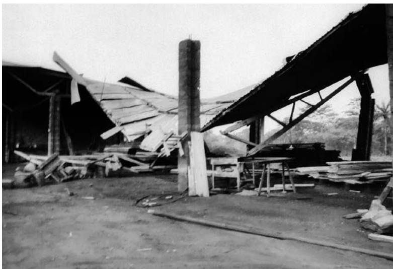
Abb. 5: Zerstörungen an den Maschinenschuppen in Agou nach dem Sturm im Februar 1967. Neben dem Bild ist vermerkt: »Agou nach dem Sturm im Febr 1967«. März 1967, BArch Koblenz B213 04113.
