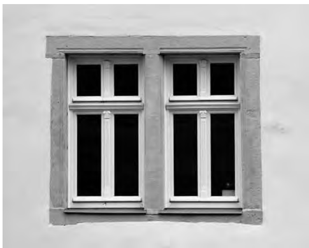
Abb. 1 und 2: Obergut Lenthe, Südfassade, im Untergeschoss Fenster mit erneuerter Stütze
