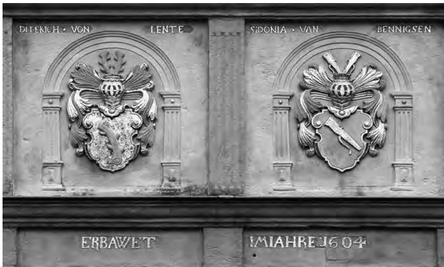
Abb. 6: Obergut Lenthe, Bauinschrift an der Auslucht (Standerker) auf der Nordseite des Herrenhauses
