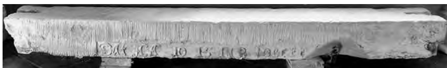
Abb. 3: Ausgebaute Fensterstütze mit Inschrift
