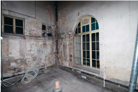
Abb. 6: Römischer Hof, Erdgeschoss. Residenzschloss Weimar, Ostflügel
