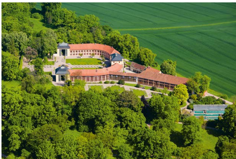
Abb. 4: Luftaufnahme der Orangeriegebäude, Schloss Belvedere, Weimar, 2017
