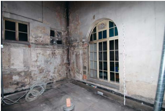
Abb. 6: Römischer Hof, Erdgeschoss. Residenzschloss Weimar, Ostflügel
