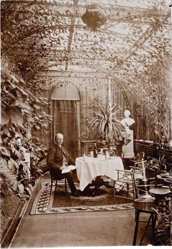
Abb. 7: Großherzog Carl Alexander im Wintergarten. Residenzschloss Weimar, Ostflügel, sogenannter »Ilm-Balkon«, um 1897/1901
