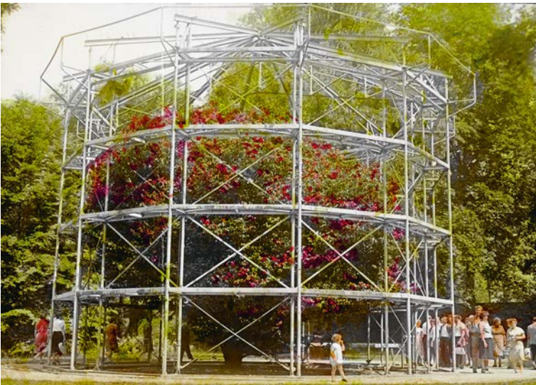
Abb. 2: Das Gerüst aus Heizungsrohren des ab 1950 genutzten Schutzhauses im Sommer, ohne die Holzverkleidung
