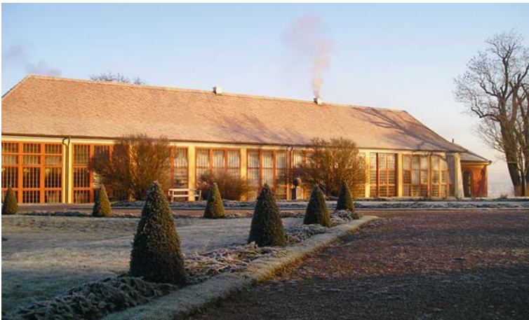
Abb. 6: Langes Haus der Orangerie im Winter mit rauchendem Schornstein , 2008
