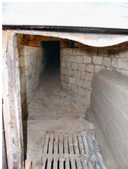
Abb. 3: Heizkanal im Nordflügel während der Sanierung, Schloss Belvedere, Weimar, 2012
